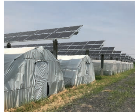
Abb. 40: PV-Module über einem Folientunnel. © BayWa r.e.
