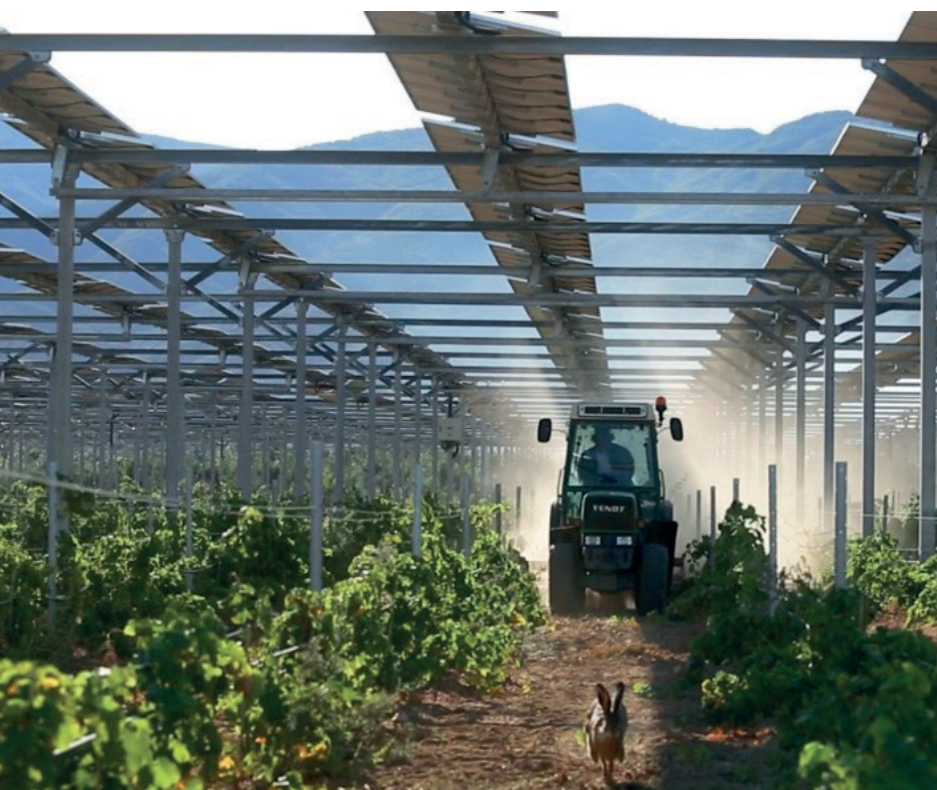
Abb. 44 Hoch aufgeständerte Anlage mit durchgängigen Modulreihen. © Sun'Agri
