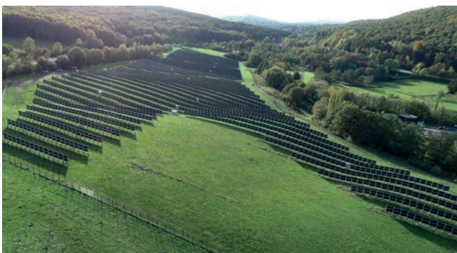
Abb. 51: Solarpark Eppelborn-Dirmingen mit 2 MW p mit vertikalen Solarzäunen von Next2Sun. © Next2Sun GmbH
