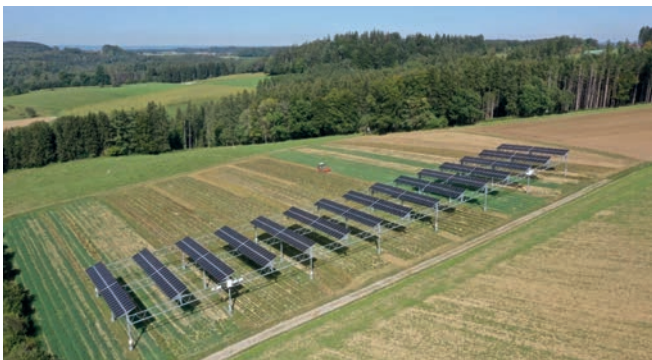
Abb. 50: Agri-PV-Anlage in Heggelbach mit einer Leistung von 194 kW p auf etwa einem Drittel Hektar. © Fraunhofer ISE
