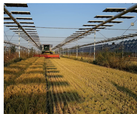
Abb. 43: Hoch aufgeständerte Anlagen mit schmalen PV-Modulen in Italien. © REM Tec
