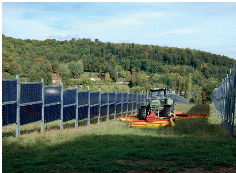
Abb. 31: Vertikal errichtete, bifaziale Module im Solarpark in Eppelborn-Dirmingen, Saarland, mit 2 MW p Leistung, errichtet von Next2Sun. © Next2Sun GmbH
