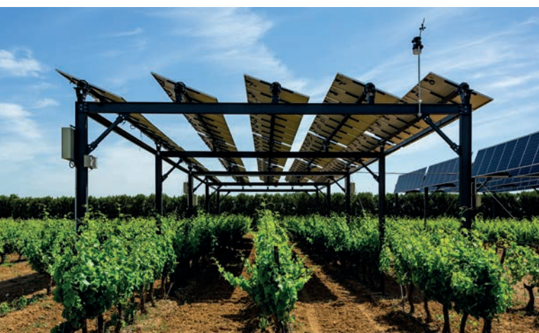
Abb. 26: Agri-PV mit nachgeführten Modulen in Frankreich. © Sun'Agri
