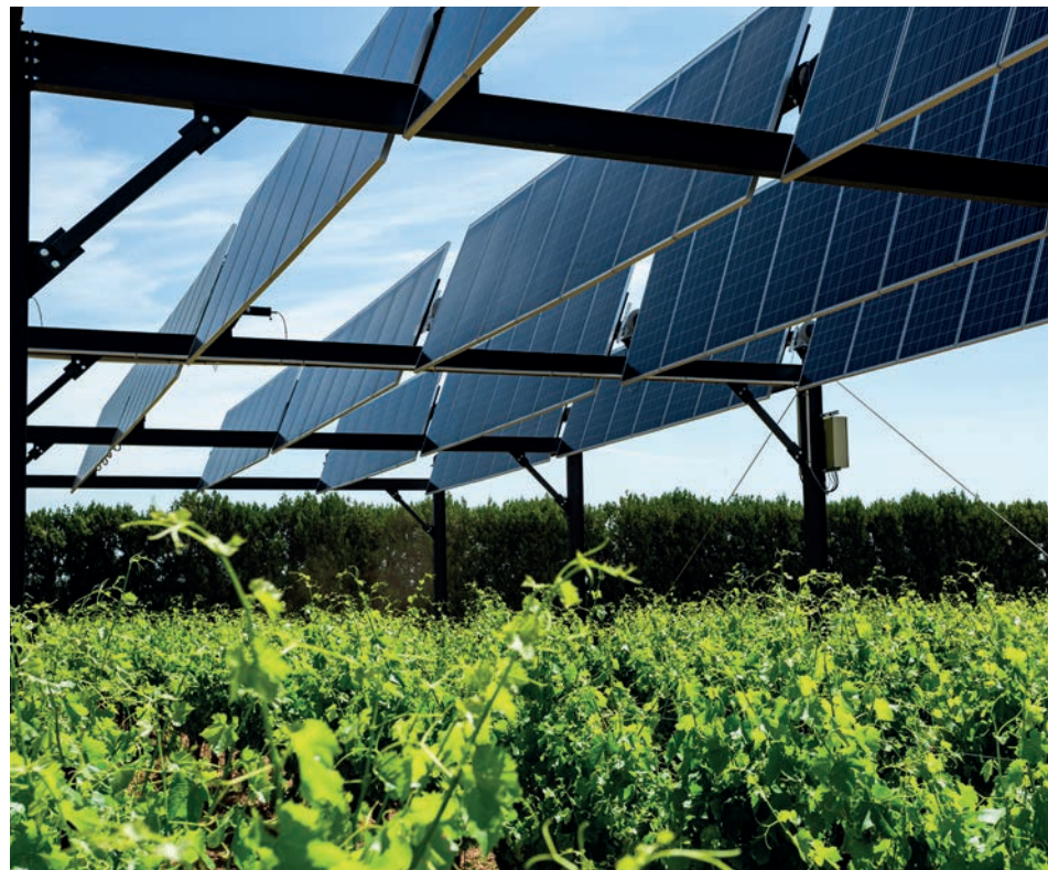
Abb. 45 Einachsiges Tracker-system einer Demonstrations-anlage in Frankreich. © Sun'Agri
